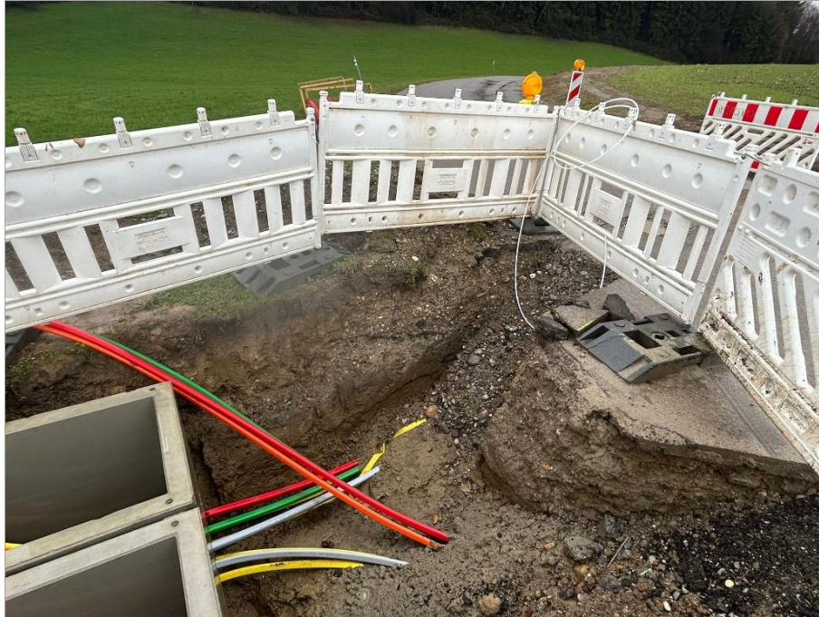
Foto 1: Blick auf die kiesige Auffüllung im Bereich des Schachtbauwerks an der Liebenweiler Straße.
