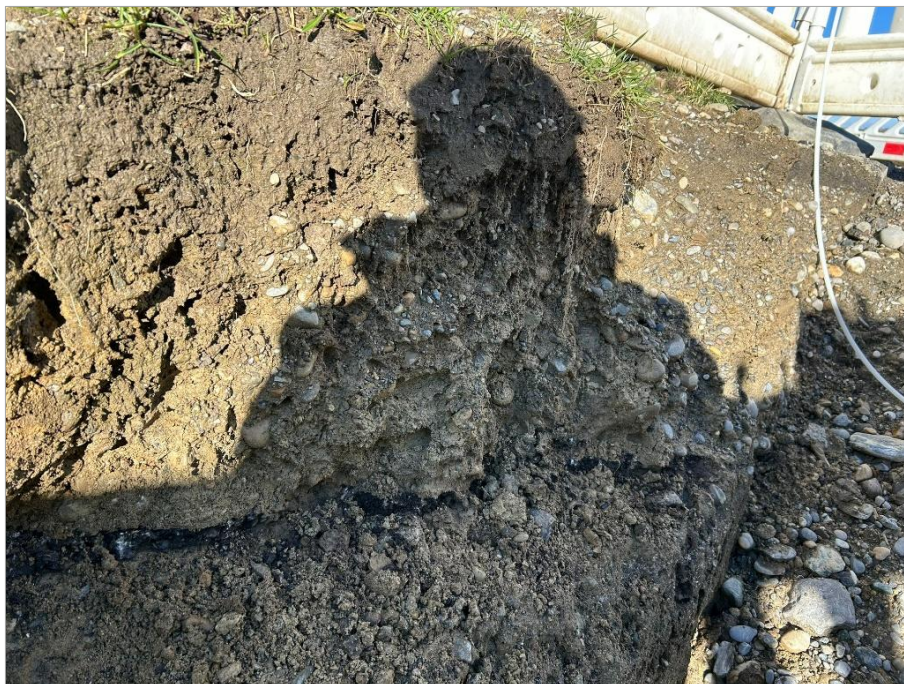
Foto 2: Blick auf die kiesige Auffüllung mit der alten Schwarzdecke im Bereich des Schachtbauwerks nahe der Liebenweiler Straße
